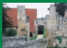
Burgruine Nippenburg Schwieberdingen
